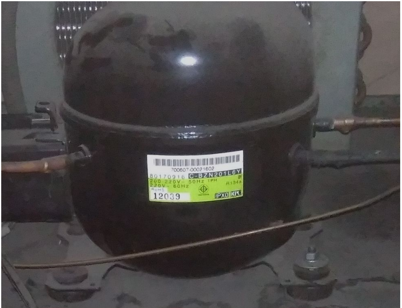
Compresseur Sanyo C-BZN201L6Y, 1 / 4cv
