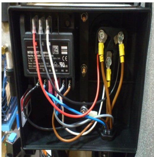
Figure 15 : Installation correcte avec presse-étoupe, boîtier électrique en IP54 (modèles TW*)
